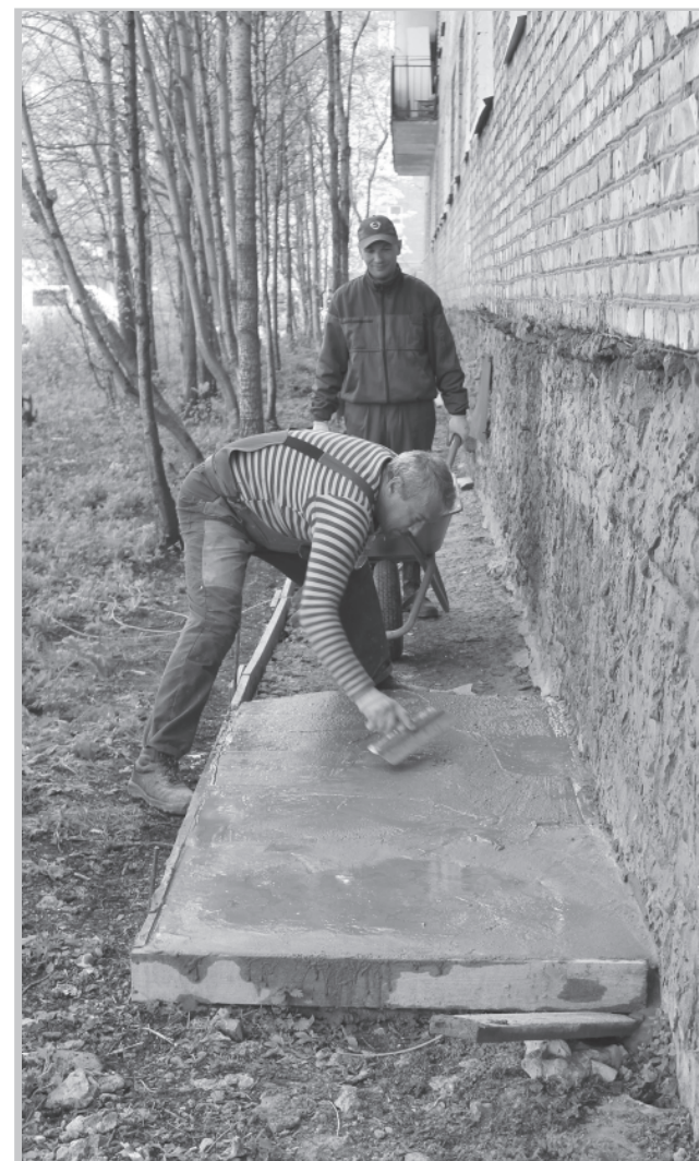
Почти тысячу квадратных метров отмостки предстоит восстановить в этом году бетонщикам «Теплоэнергосервиса»
