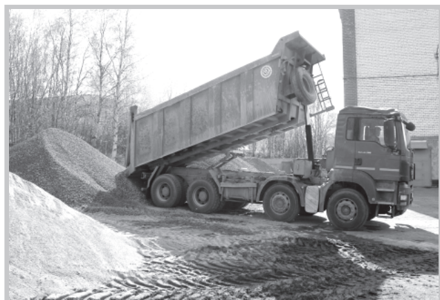
Общий объем работ по ремонту асфальтового покрытия во дворах составит 1 870 квадратных метров.
