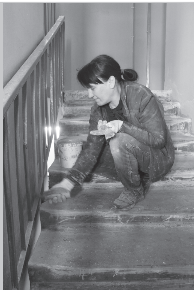
В этом году в плане значатся ремонт в 78 подъездах, работы в 20 уже выполнены.
