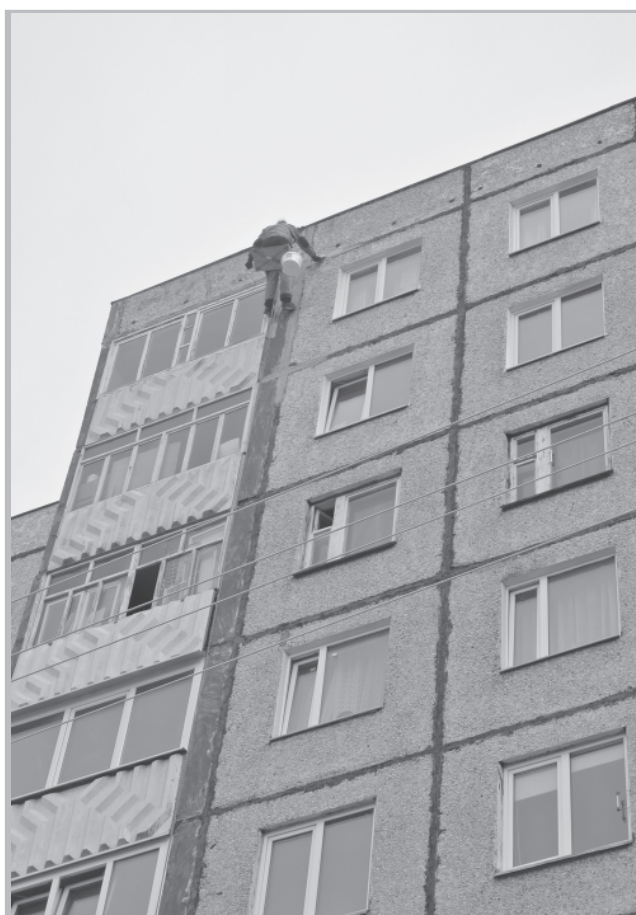
Промышленным альпинистам предстоит загерметизировать 3 тысячи погонных метров межпанельных швов.
