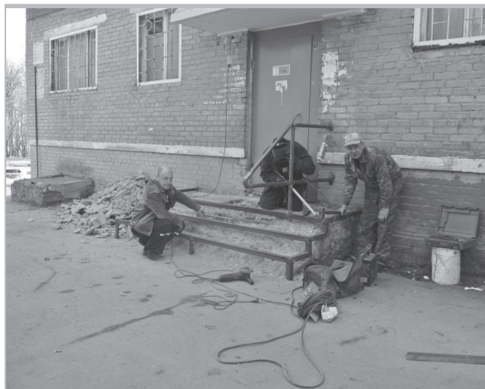
Лето — самая жаркая пора для управляющей компании. Сейчас в самом разгаре сезонные работы. За короткое лето нужно отремонтировать 137 крылец.
